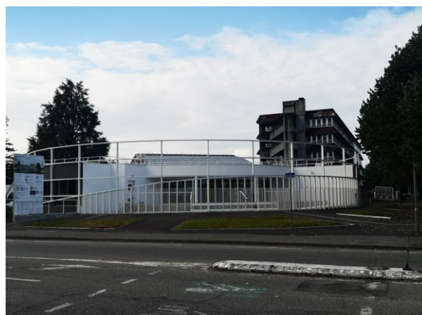
Vue extérieure du bâtiment Ferry (chantier)
