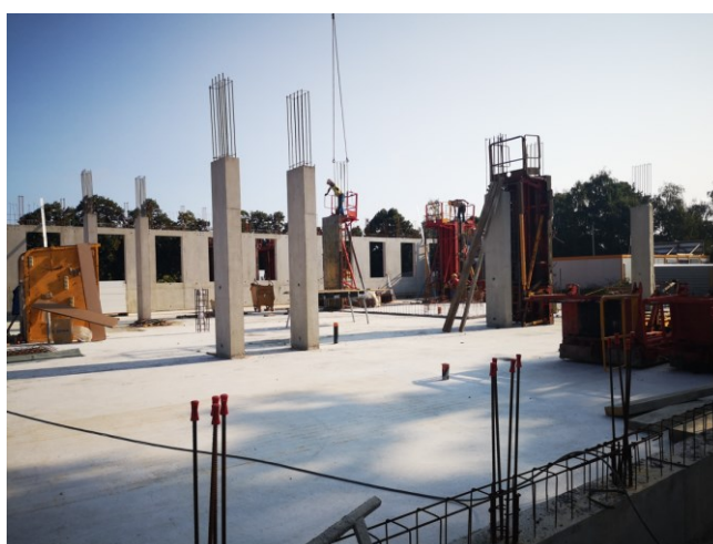
Vue du chantier en cours
