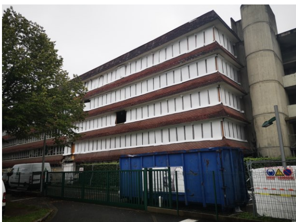
Vue extérieure bâtiment D'Alembert (chantier)
