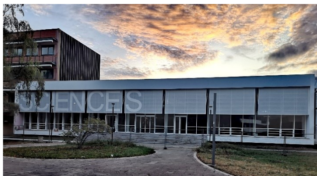
Façade principale du bâtiment A après les travaux
