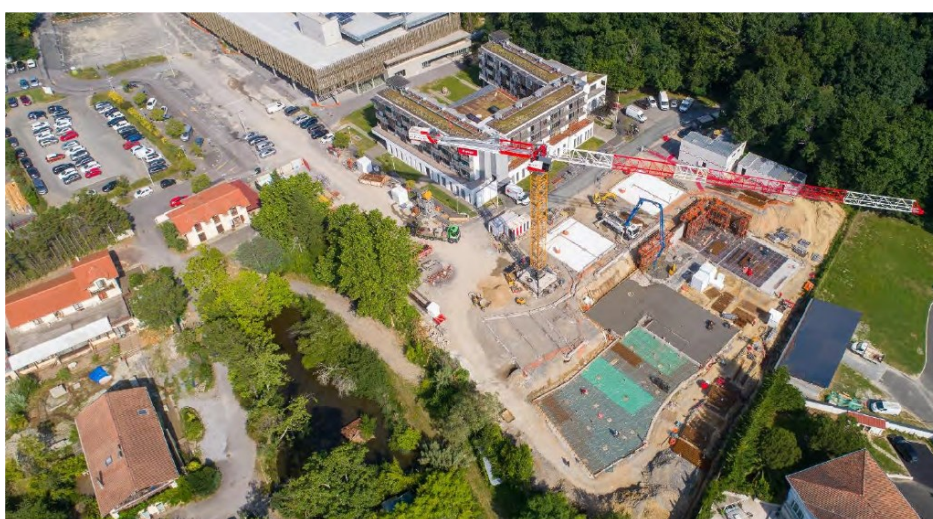
Vue du chantier en cours
