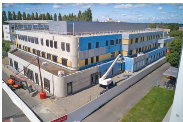
Vue extérieure (chantier en cours)
