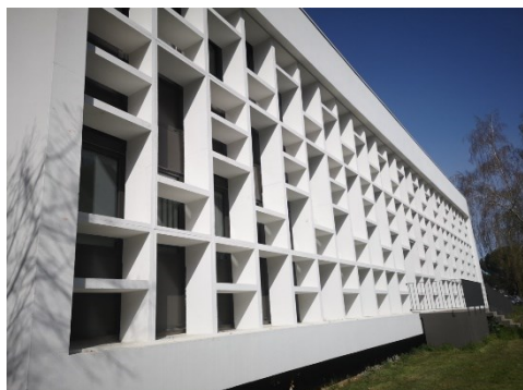
Façade arrière du bât. A après les travaux
